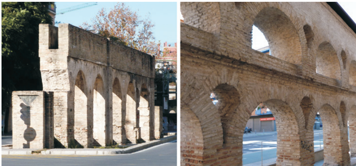
Figura 8. Fotografías de dos de los tramos conservados de los Caños de Carmona. A la izquierda, en la antigua Alcantarilla de las Madejas y, a la derecha, en la calle Luis Montoto.
